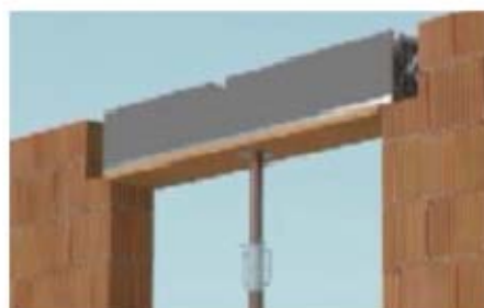
Alignement, étayage et mise à niveau du coffre centré
