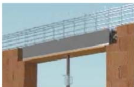
Pose de l'armature
