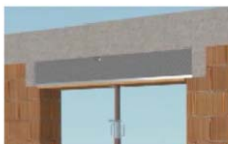
Réalisation de la poutre
