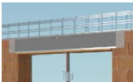
Colage du béton entre coffre et maçonnerie
